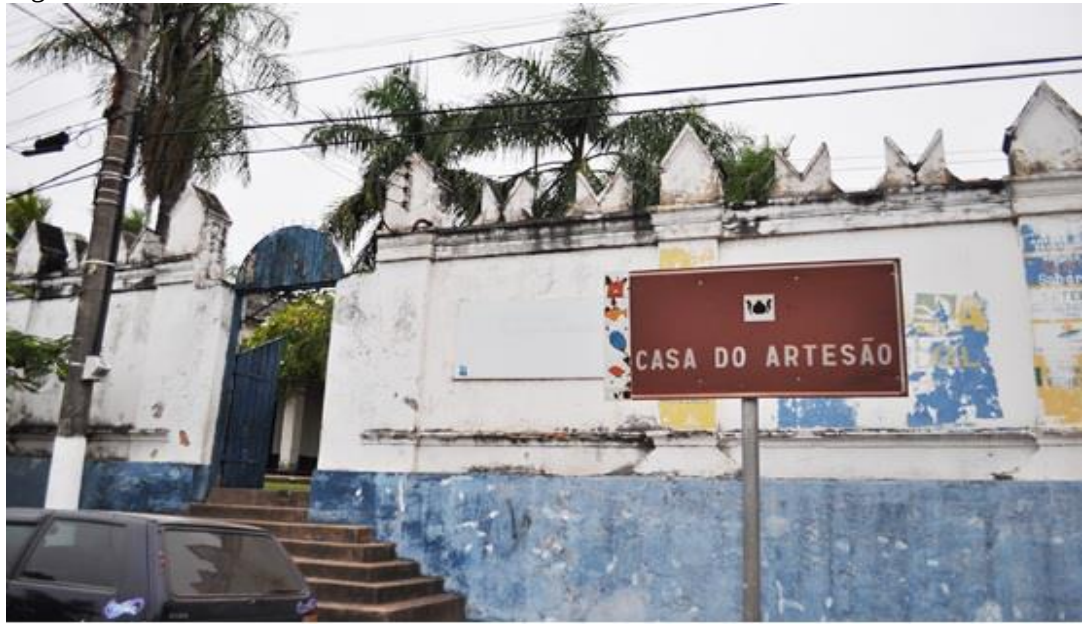
Figura 3. Fachada da Casa do Artesão
