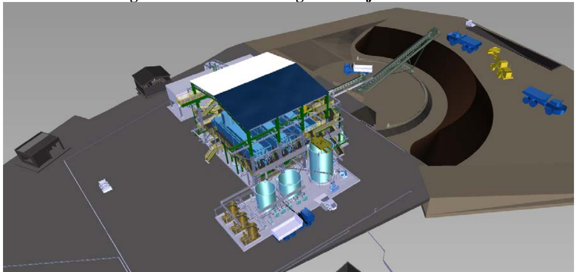
Figura 4 - Planta de Filtragem de Rejeitos
