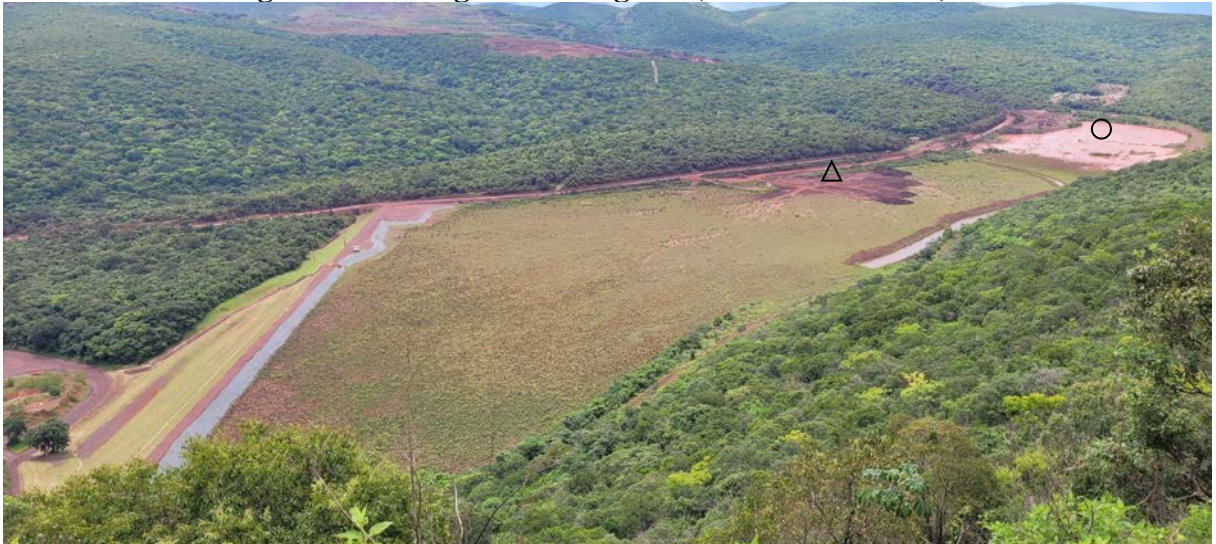
Figura 5 - Barragem do Gregório (Mina Santa Cruz)
